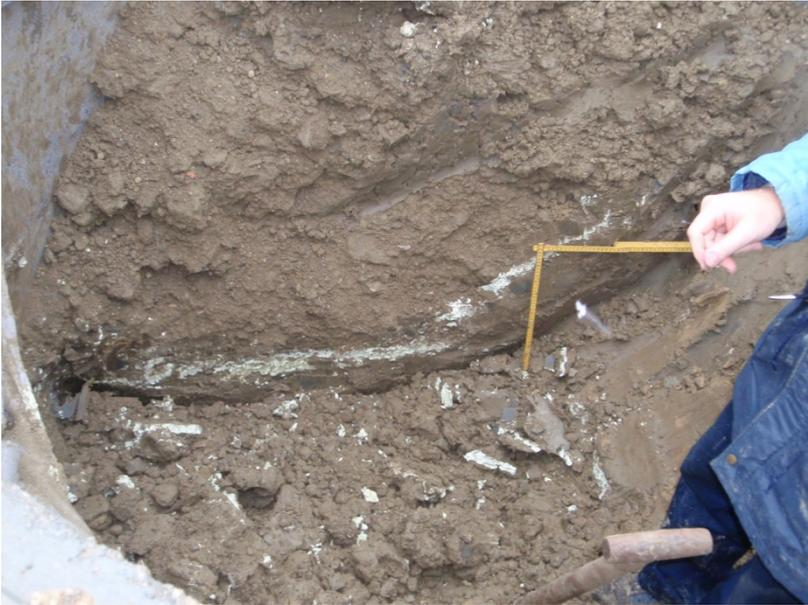
Abbildung 13, Ausbreitung des Injektionsgutes im Tegel
