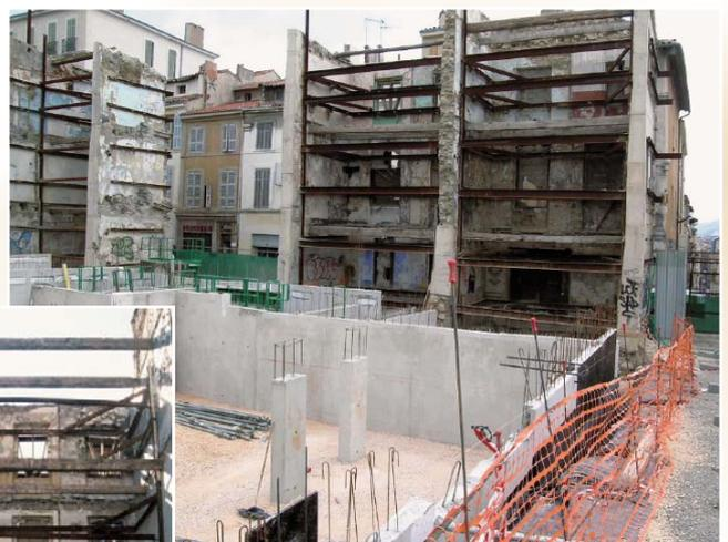
Die Bodenstabilisierung wird unter der alten Fassade bis zu der vorgesehenen Fundamenttiefe des neuen Bereichs ausgeführt
